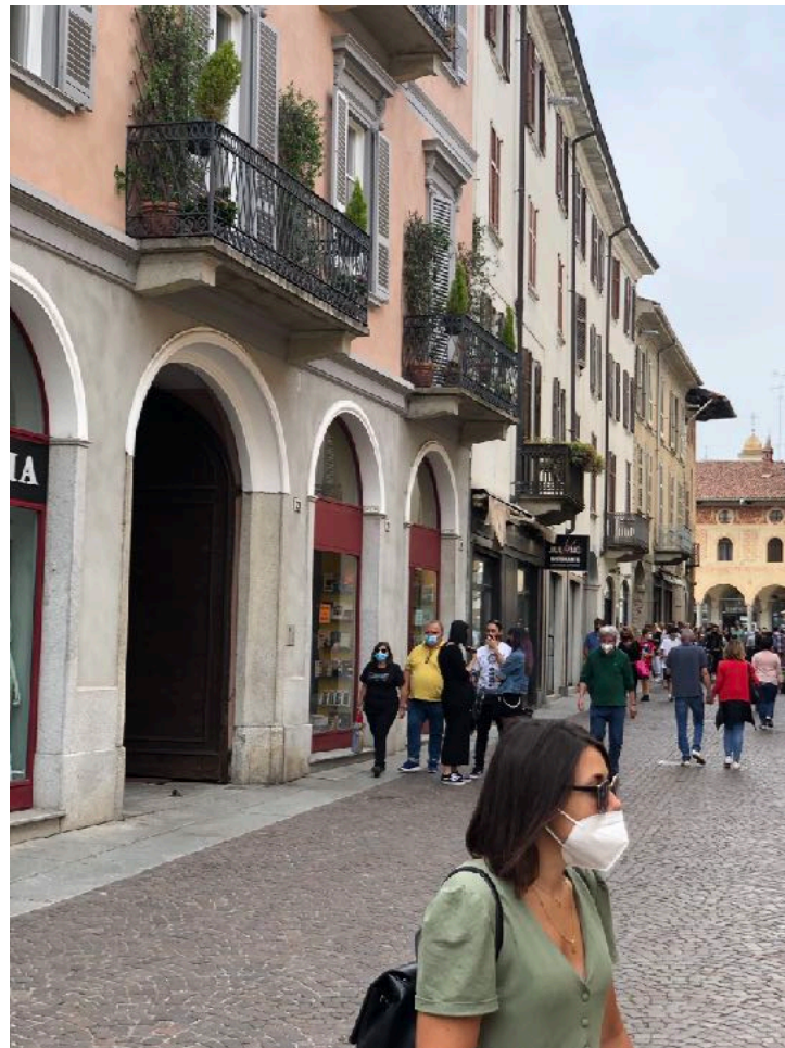
Fassade mit Sumpfkalkprodukten von ET, 5 Jahre alt, Altstadt Vigevano
